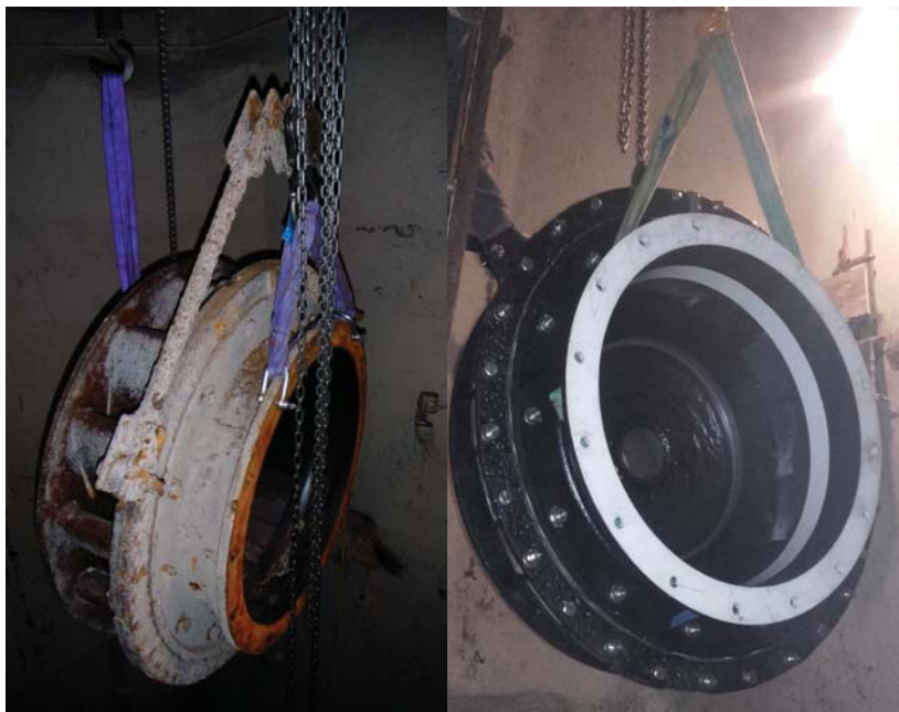
Turbinenleitringe: vor- und nachher
