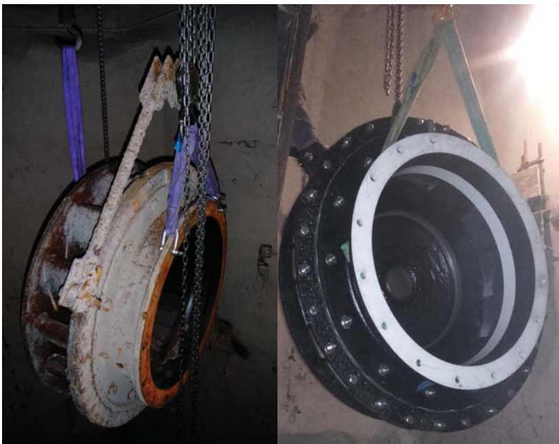
Turbinenleitringe: vor- und nachher
