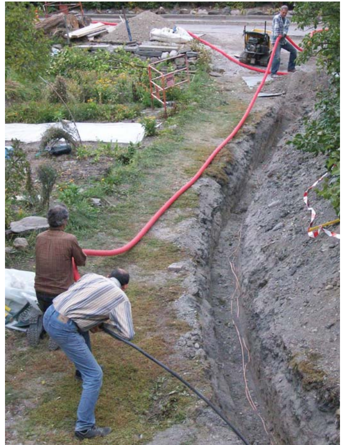
Verlegung der Stromkabel
