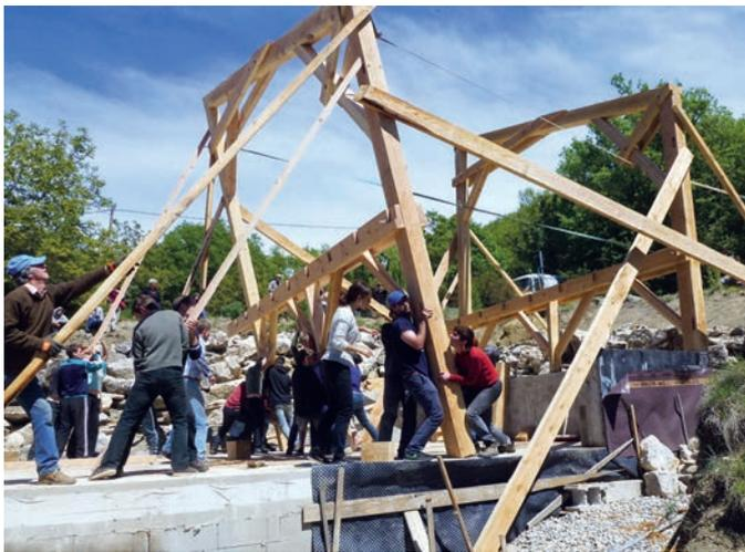
**Bau des neuen Generationenhauses. Grosseinsatz beim Errichten des Dachstuhls.**
